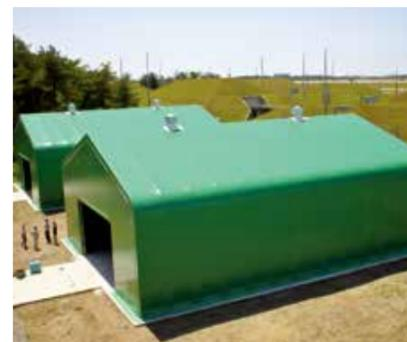
ベンチレーター(自然換気、強制換気)
